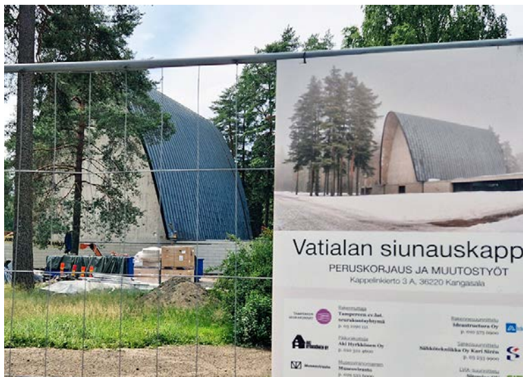
Vatialan kappelin peruskorjaus valmistui vuodenvaihteessa.
