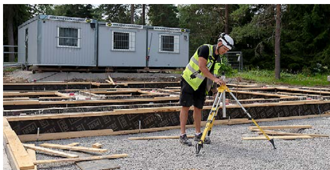
Tuukka Pyöriä asetteli tasolaserin kolmijalkaa Vatialan hautausmaan huoltorakennustyömaalla heinäkuussa.
